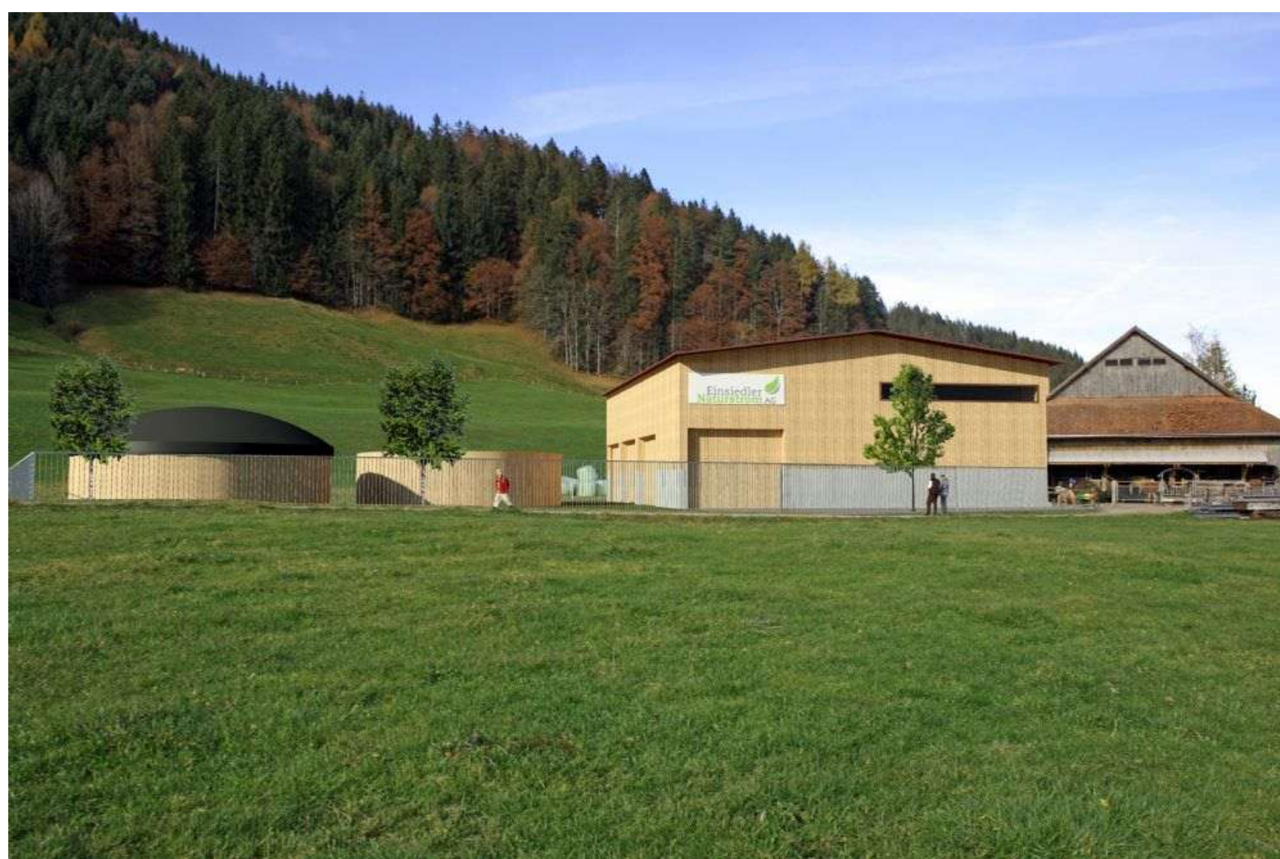
Aus Hofdünger entsteht in Trachslau Strom und Wärme.
